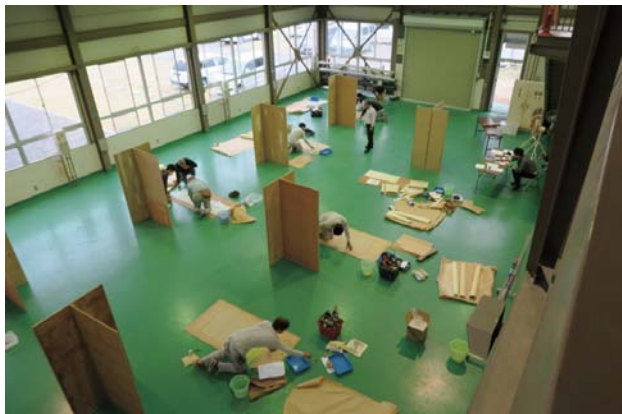
技能検定トライアル（実技） 壁装
